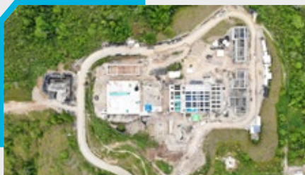
Planta de Tratamiento de agua potable Rafael Ardila Duarte. Capacidad de 1200 l/s, Bucaramanga, Colombia.
