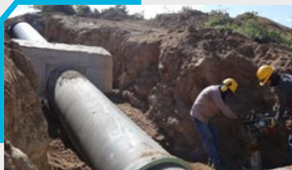
Conducción entre la planta de tratamiento de agua potable Rafael Ardila Duarte y el tanque ferrovías, Tubería HD, longitud 3000m de diámetro 1000 mm. Bucaramanga, Colombia.
